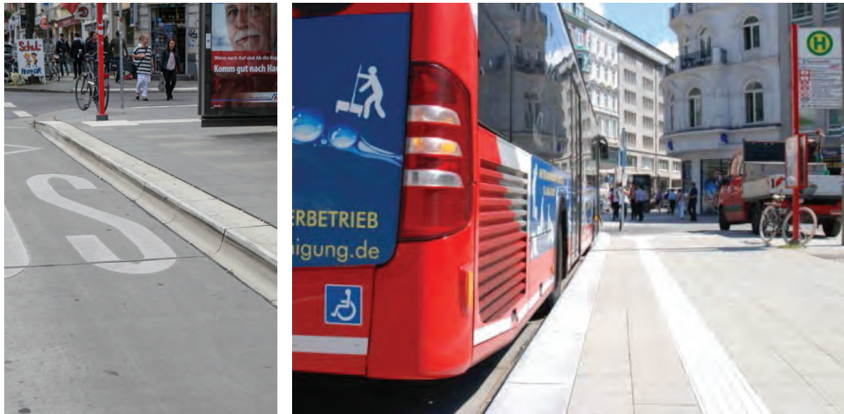
Abb. 2: Haltestelle mit Sonderbord, HVV 2015/ Hochbahn 2014.
