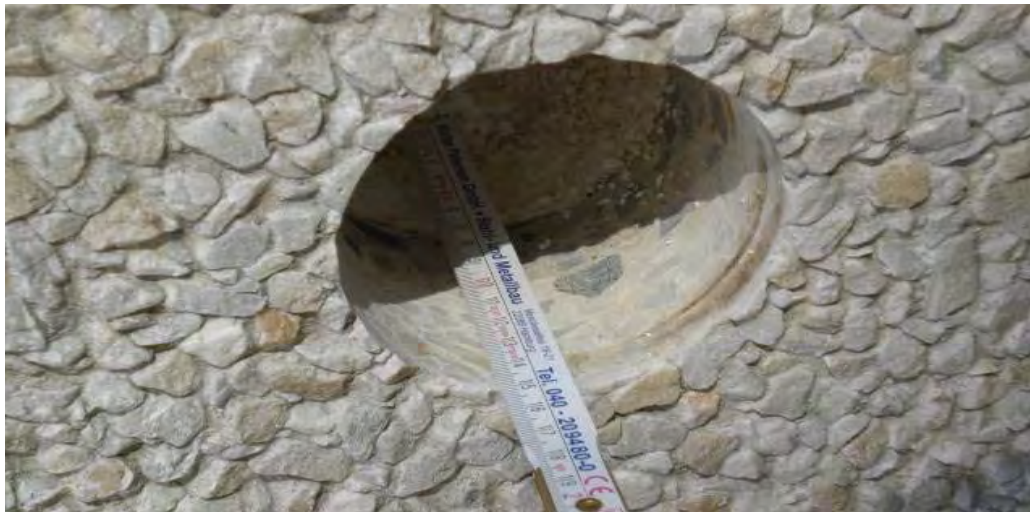
Abbildung 9: Kernbohrung durch Sandwichelement
