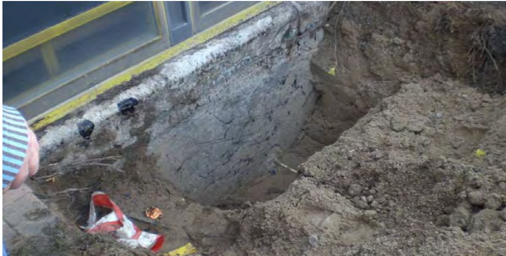
Abbildung 10: Schürfgrube an südlicher Außenwand des Turnhallengebäudes
