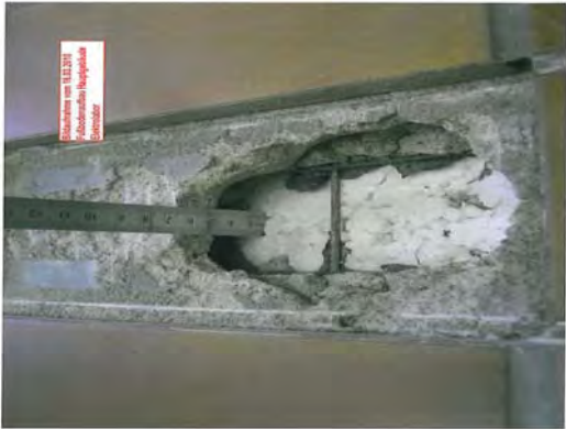
Fußbodenaufbau Hauptgebäude Elektrolabor
