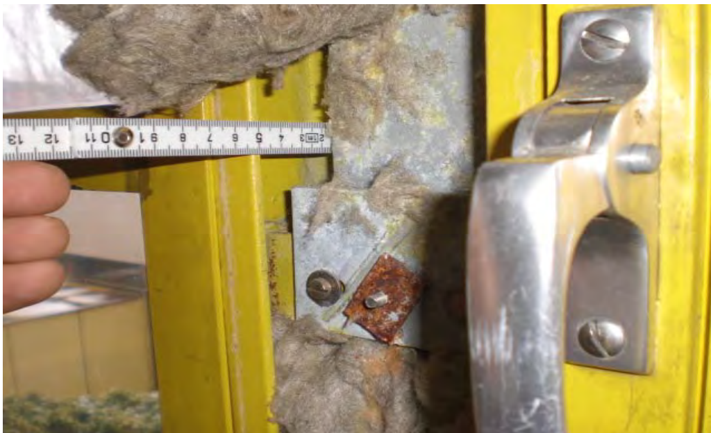
Abbildung 59: Fassadenelementstoß innen nach Rückbau des Verkleidungsbleches
