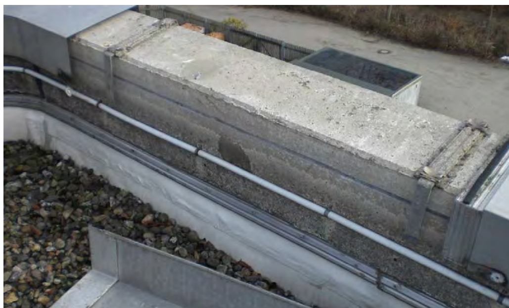
Abbildung 63: Rückbau der Attikaverkleidung auf Dachfläche des Schulgebäudes
