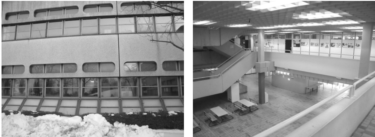
Abbildung 1: Außen- und Innenansichten berufliche Schule in Bad Oldesloe (Januar 2010)
