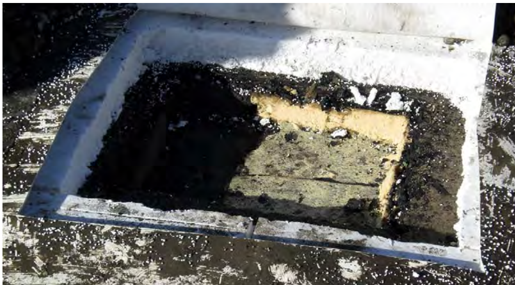
Abbildung 7: Rückbau der Bestandsdichtung und Dämmung auf Dachfläche Schulgebäude
