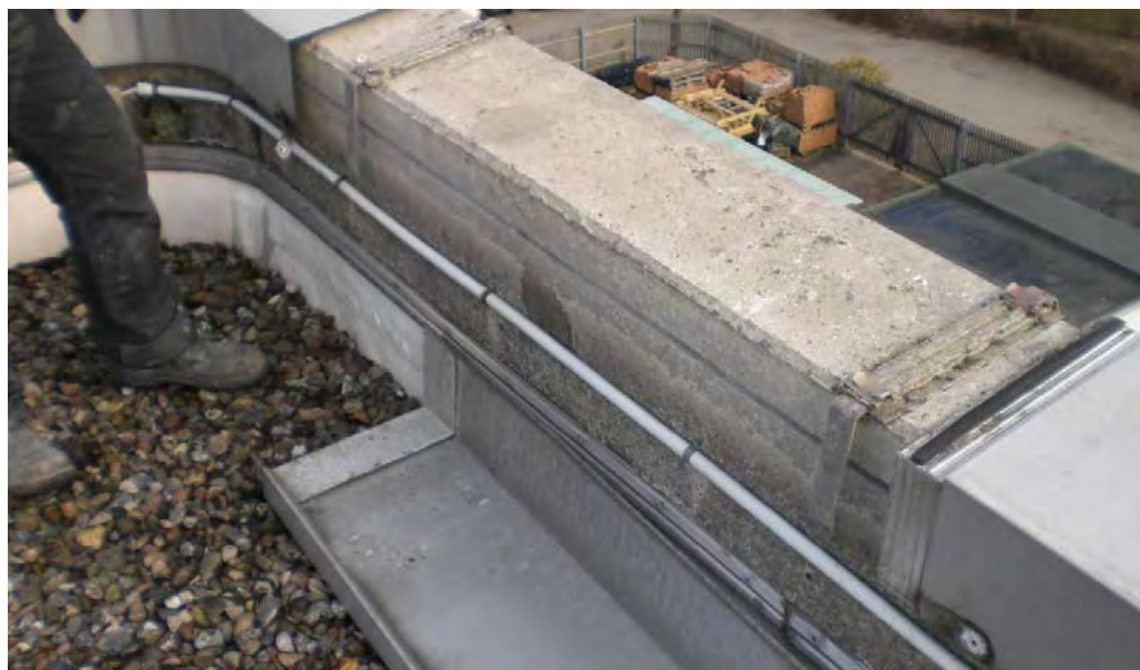
Abbildung 62: Rückbau der Attikaverkleidung auf Dachfläche des Schulgebäudes
