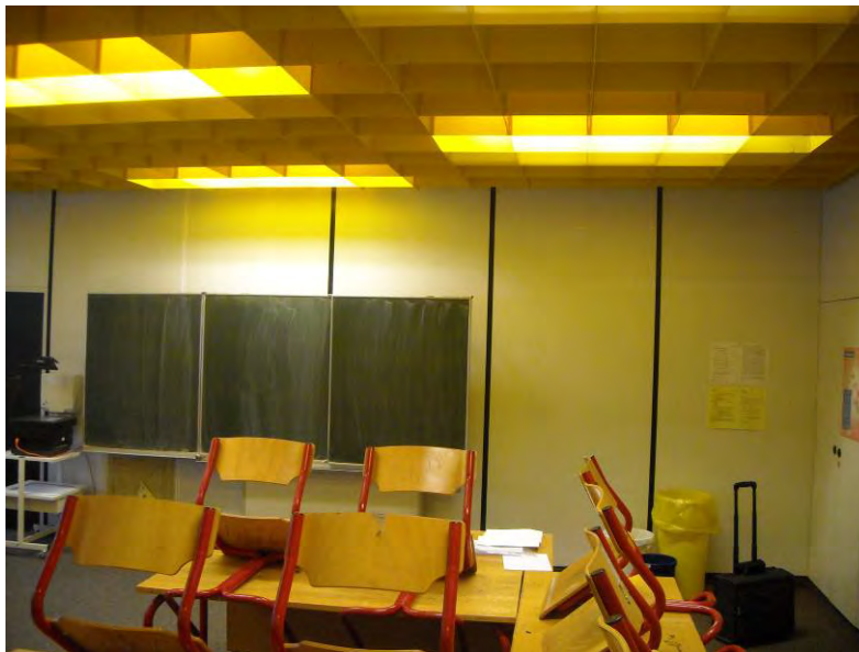
Abbildung 20: Klassenraum E48 mit Lamellenrasterdecke
