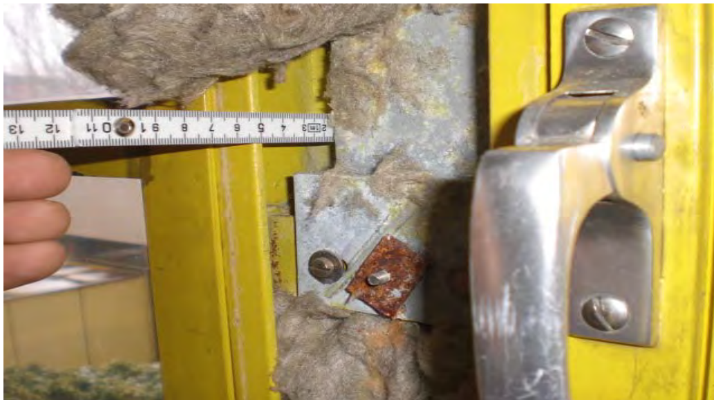
Abbildung 8: Fassadenelement Stoß innen nach Rückbau des Verkleidungsbleches
