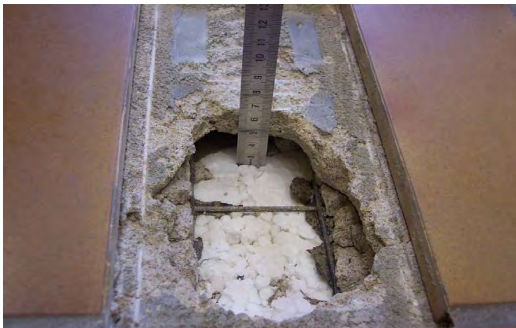
Abbildung 65: Feststellung des Fußbodenaufbaus im Elektrolabor des Schulgebäudes
