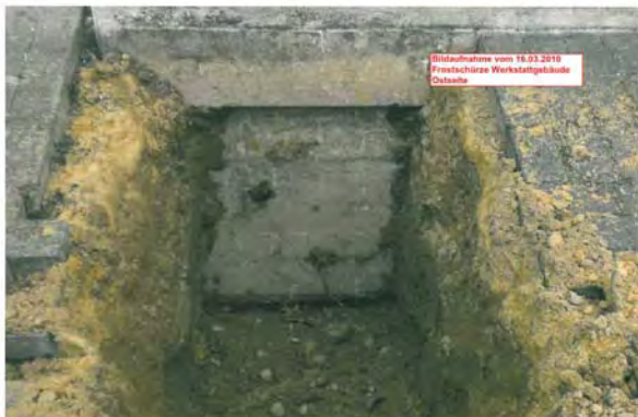
Frostschürze Werkstattgebäude Ostseite
