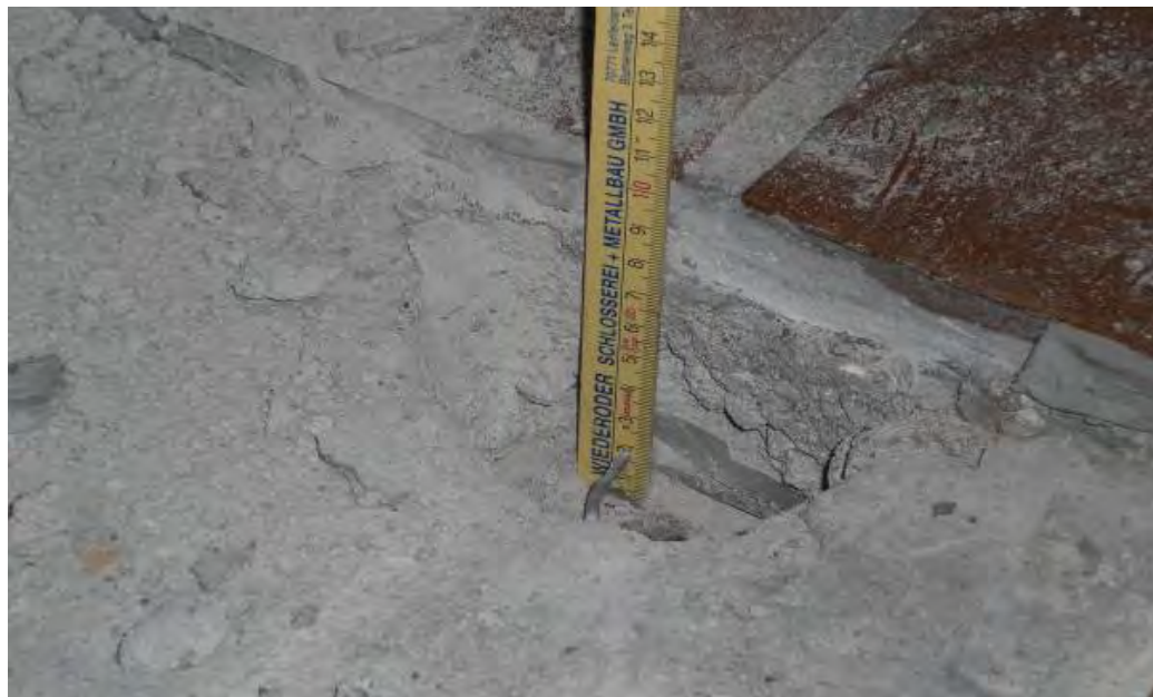
Abbildung 11: Feststellung des Fußbodenaufbaus im Foyer des Schulgebäudes
