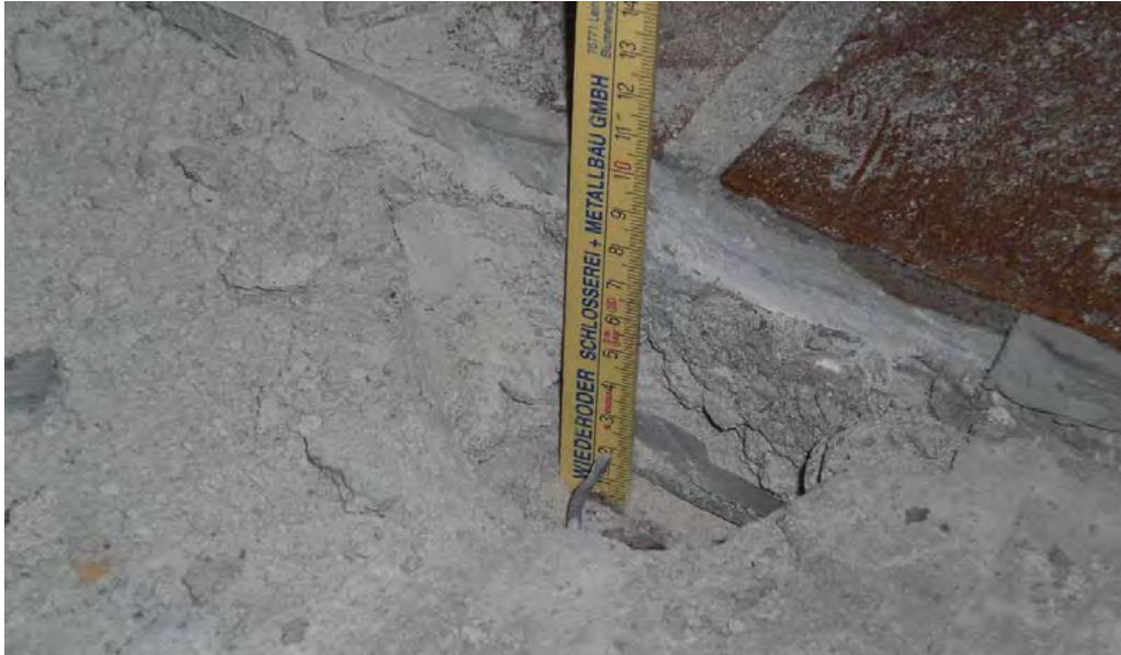
Abbildung 66: Feststellung des Fußbodenaufbaus im Foyer des Schulgebäudes
