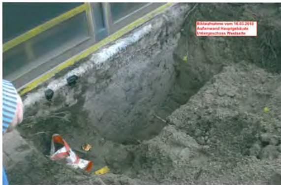
Außenwand Hauptgebäude UG Westseite
