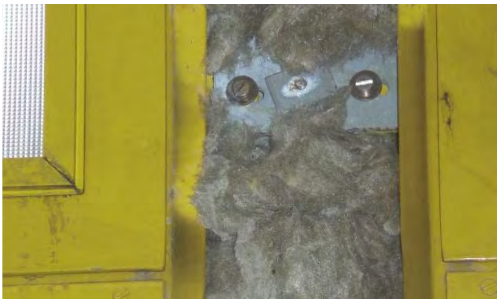
Abbildung 61: Mineralwolle im Bereich des Fassadenelementstoßes
