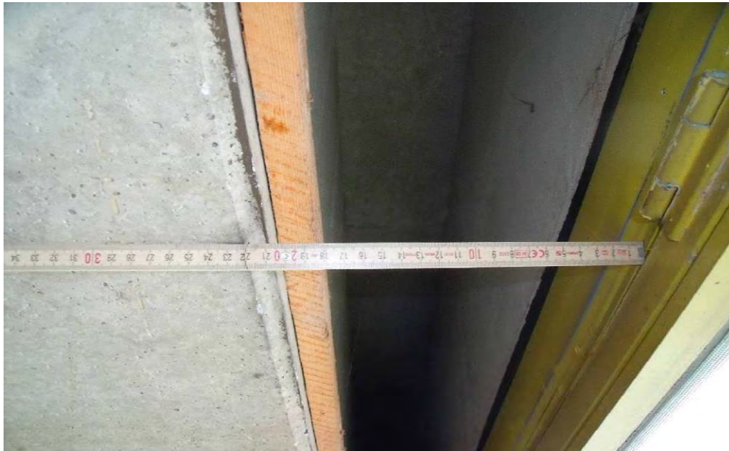
Abbildung 64: Einblick in Hohlraum (innen) oberhalb des Fassadenkopfpunktes
