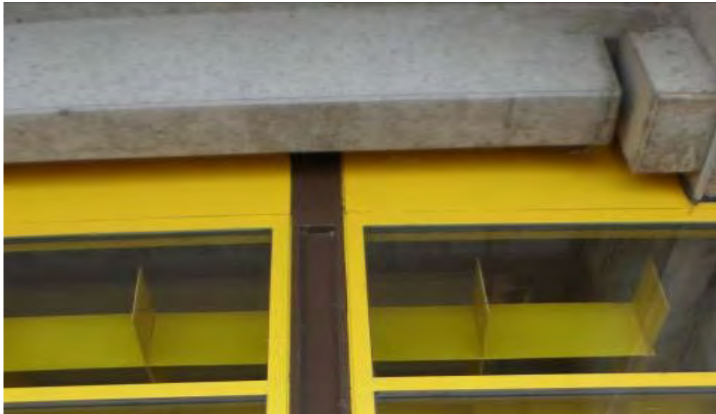
Abbildung 58: Fassadenelementstoß außen
